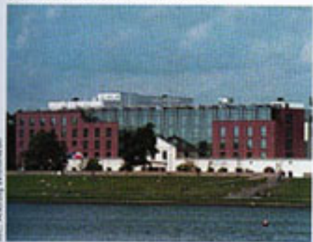
hotel Sheraton, proj. N.V. BESIX, S.A.
